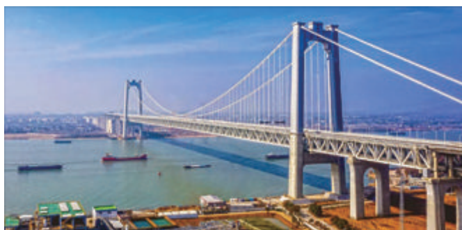
世界首座高速铁路悬索桥——五峰山长江大桥 Wufengshan Bridge – the world’s first high-speed suspension bridge
