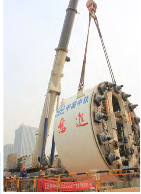
武汉地铁3号线盾构下井
