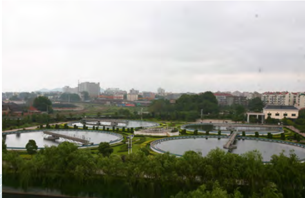
马鞍山中铁水务公司二沉池
