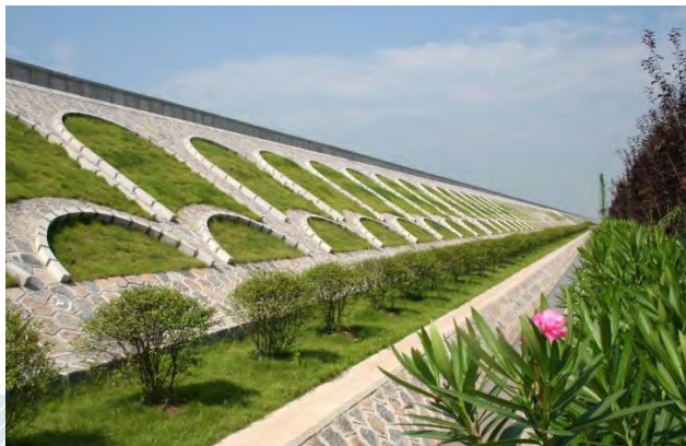
路基边坡绿化
